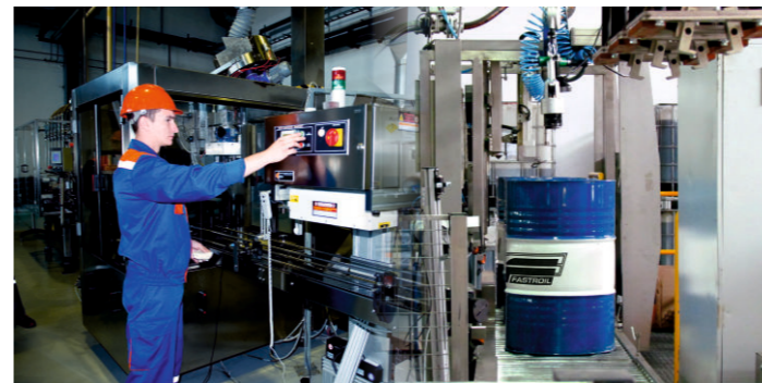
Автоматические линии розлива, системы подачи и подогрева бочек, система распределения продукции
