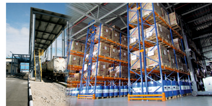
Погрузочные/разгрузочные подъездные пути и склад готовой продукции
